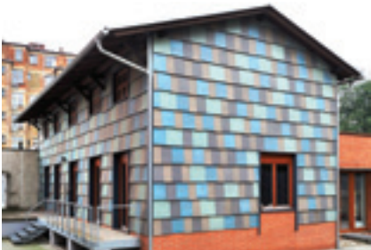
8 Dům Šupináč Ostrava - adaptace skladu na kanceláře. Autoři: Létající inženýři. (foto: Martin Nedvěd)
