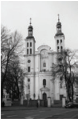
il. 12 Bazylika mniejsza pw. Narodzenia Najświętszej Marii Panny (foto: Patrycja Wąs)
