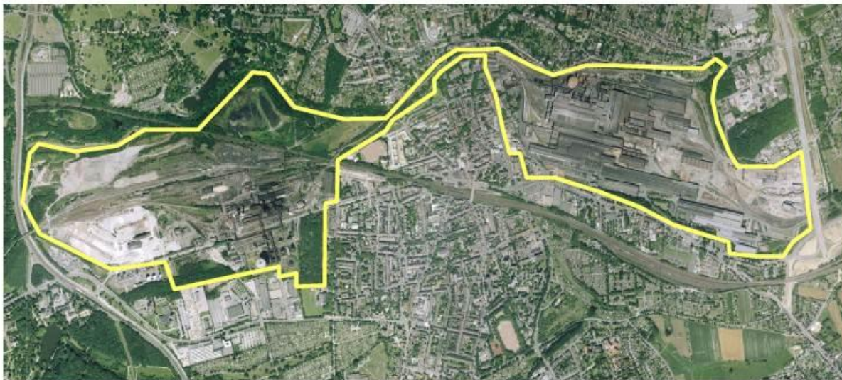
Obrázek 7 - Letecký pohled na bývalý Phoenix železářny a ocelárny v okrese Horde – Před demolicí v r. 2001.
